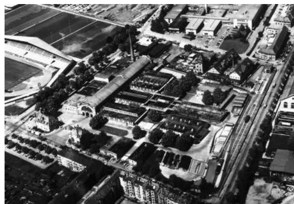
Aerial view of the slaughterhouse Zurich, 1909. Source: Baugeschichtliches Archiv der Stadt Zürich
